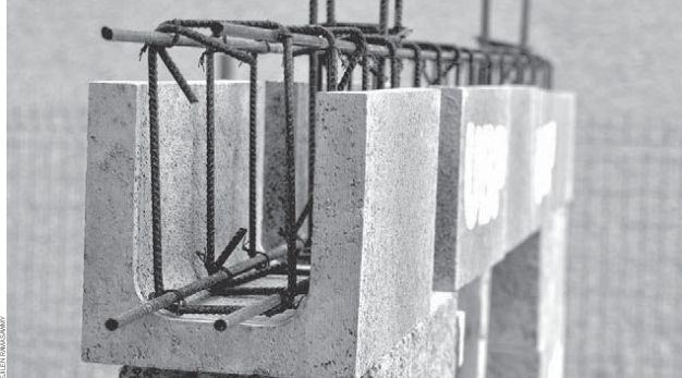
Le «U-block» permet d'éliminer le coût du coffrage, car il suffit de placer l'armature métallique dans les parpaings avant d'y couler le béton.
